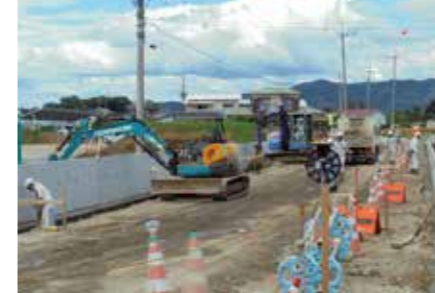
道路築造工事の土工作業風景
